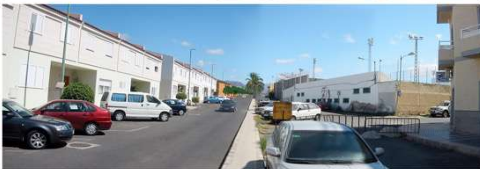
Vista actual del sector desde la calle Maldonado y con la Alternativa 3 del Plan Parcial.
