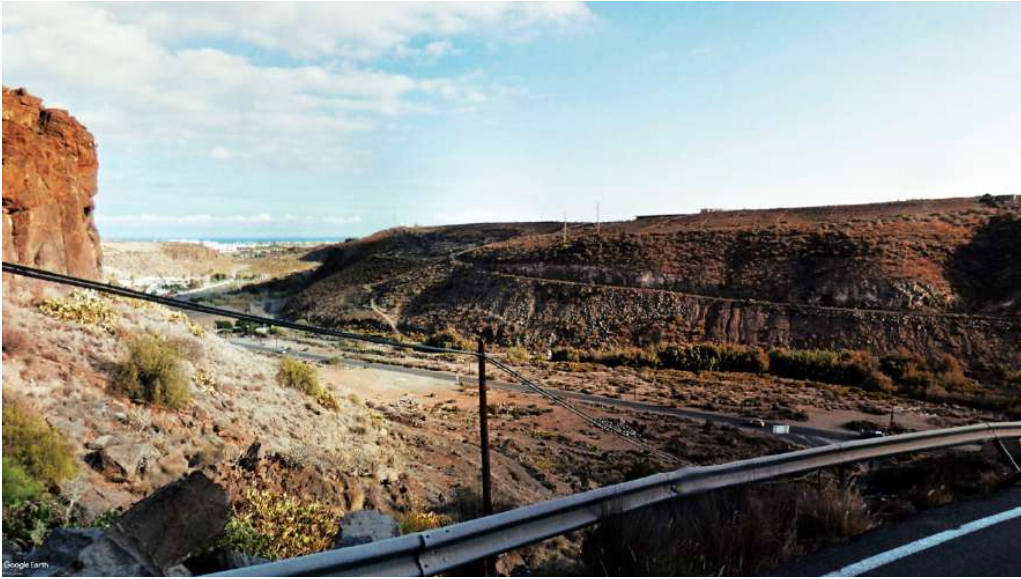
ANTES: Vista del Sector 13 TABLERO BETANCOR desde el norte, subida a Montaña La Data.
