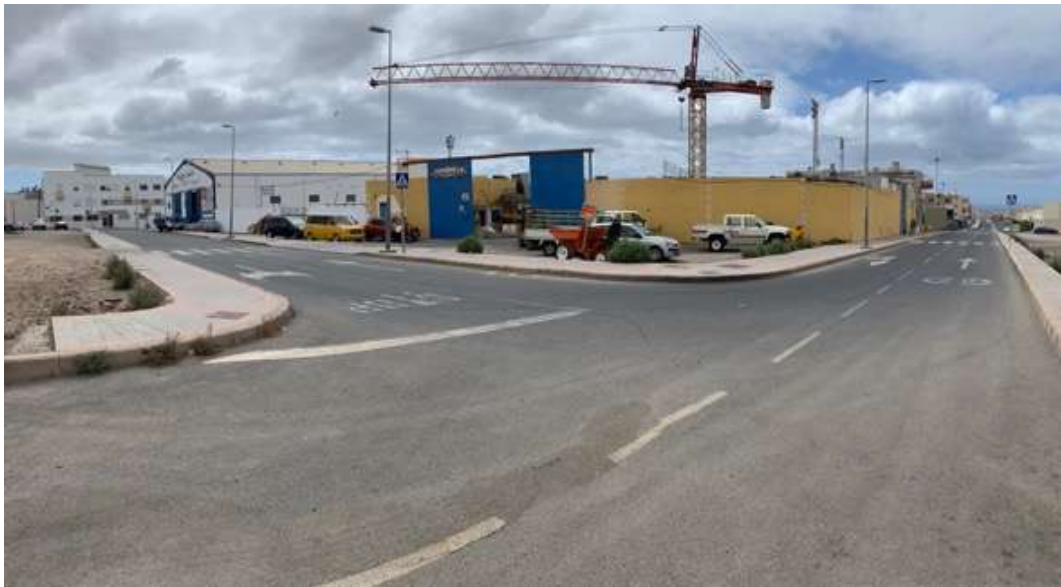
FACHADA URBANA CALLE PUERTO RICO
